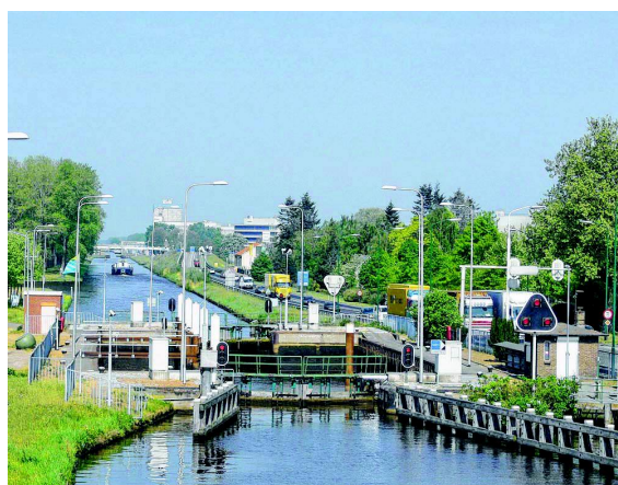
Die Schleuse von Veghel.
